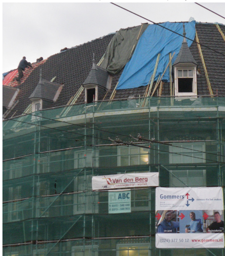
Foto 1 Renovatie oude postkantoor Velp najaar 2012
