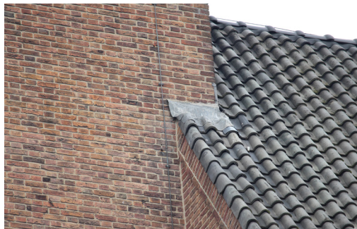
Figuur 3. Invliegopening Paasbergkerk aansluiting loodslab
