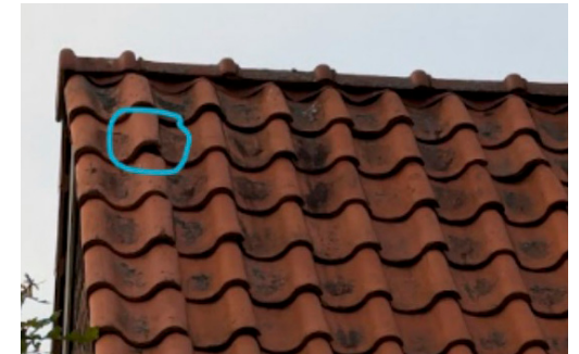
Figuur 6 invliegopening kierende dakpan Adama van Scheltemastraat 12
